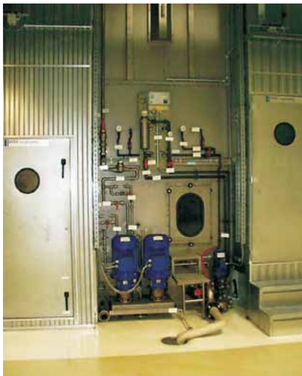
VW Poznań, Centrale KMW ZR z komorami zraszania
